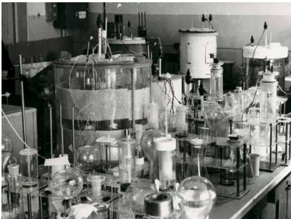
В магнитной лаборатории была изготовлена оригинальная аппаратура для изучения фаз и фазовых переходов I рода по скачку теплоемкости в критических точках, а также аппаратура для построения кривой температурной зависимости коэрцитивной силы.
