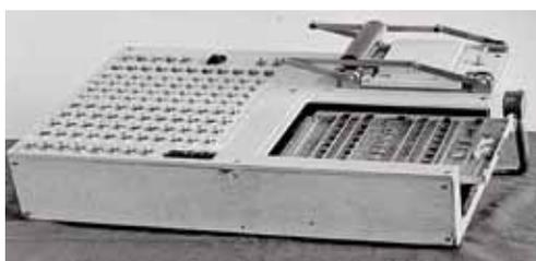
Прибор контроля плат СПУ-4, СПУ-4М, СПУ-5 и преобразователя угол–цифра. В приборе установлена одна из печатных плат для контроля
