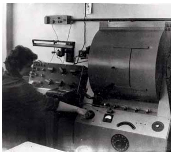
Установка для исследования электрических параметров полупроводников
