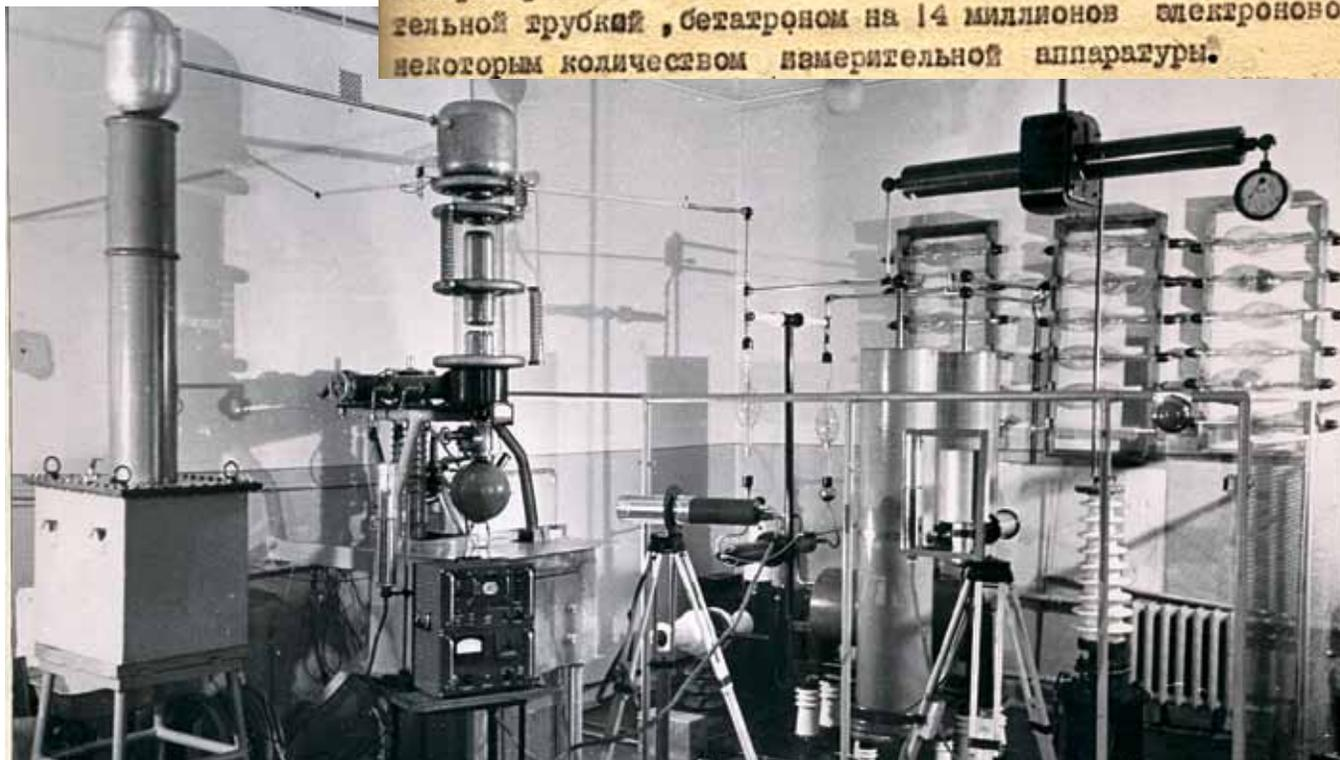
Оборудование лаборатории ядерной физики. В центре фотографии – ионный ускоритель; справа – генератор постоянного тока; слева – разделительный трансформатор, питающий высокочастотный источник дейтерия
